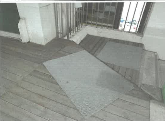
수영장 입구 나무 바닥 미그럼 매트 탈거 되어 재 설치
