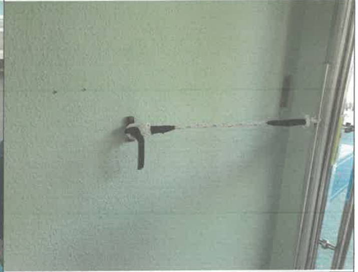
1층 주차장 출입구 출입문 고정 걸이 설치
