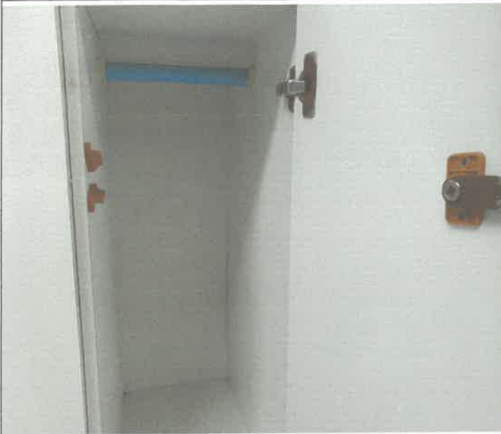
수영장 여자 탈의실 사물함 정비
