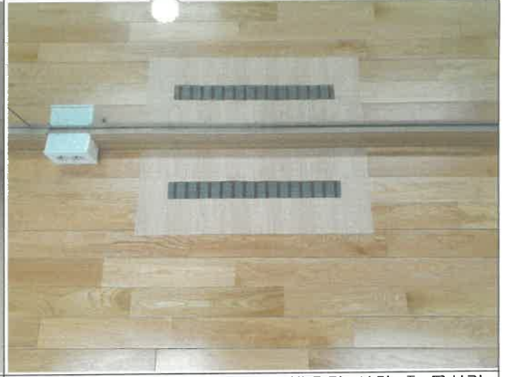
지하 소체육관 바닥 환기 통로 방충망 설치 후 모서리 시트지 부착
