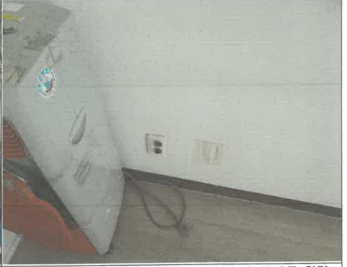
헨덴실 아마데우스실 (프)4실 전기 통신 콘센트 철거 및 교체
