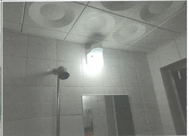
수영장 여자 샤워장 내 벽 등 1개소 교체
