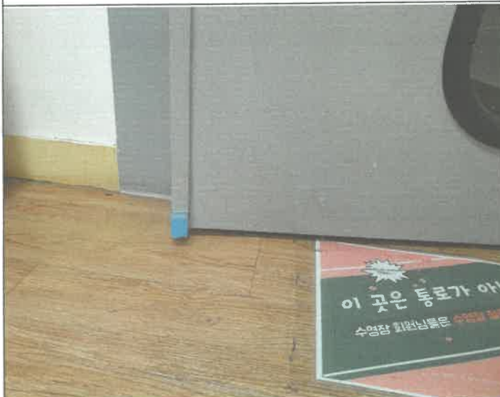
지하 1층 소체육관 방화문 하단 모서리 안전 스펀지 부착
