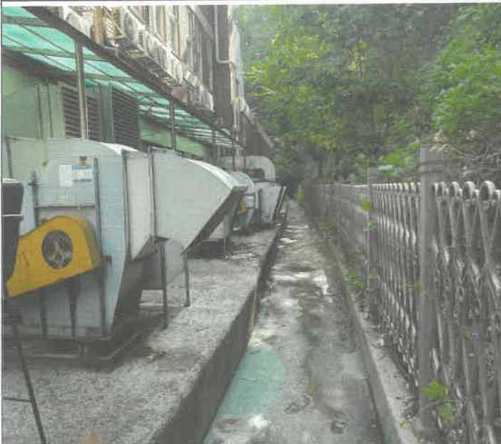
건물 후면 각종 배기팬 점검 및 구리스 주입
