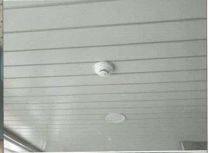
1층 체육관 입구 방풍실 내 연기 감지기 불량 교체
