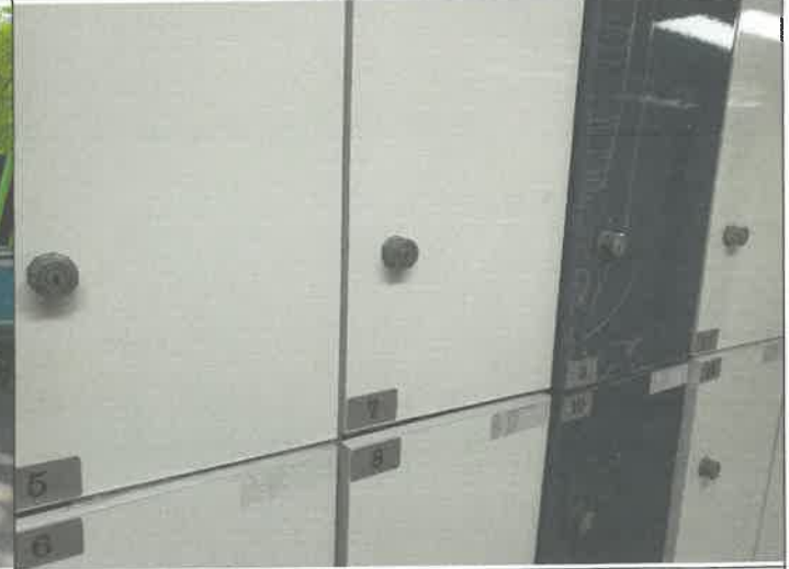
수영장 남자 탈의실 락카 1기 문짝탈락 보수
