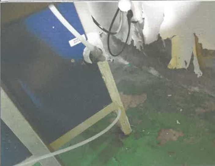
염소 발생기 소금 탱크 호스 멤브린셀 연결 엘보 탈거 되어 운행 정지 재설치 후 정상 가동
