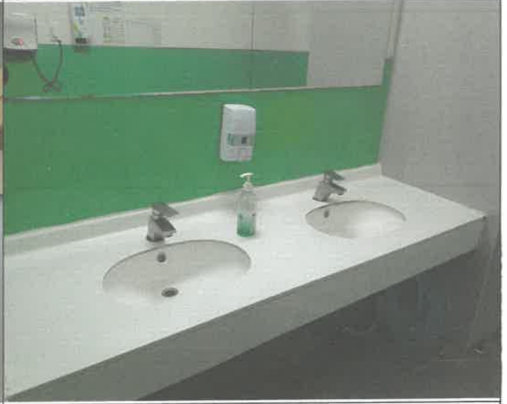
2층 여자 화장실 세면대 통수
