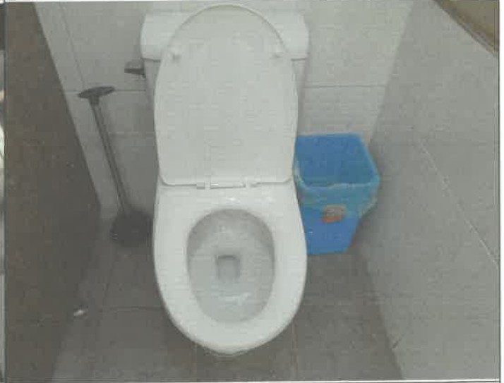
1층 남자 화장실 변기 통수
