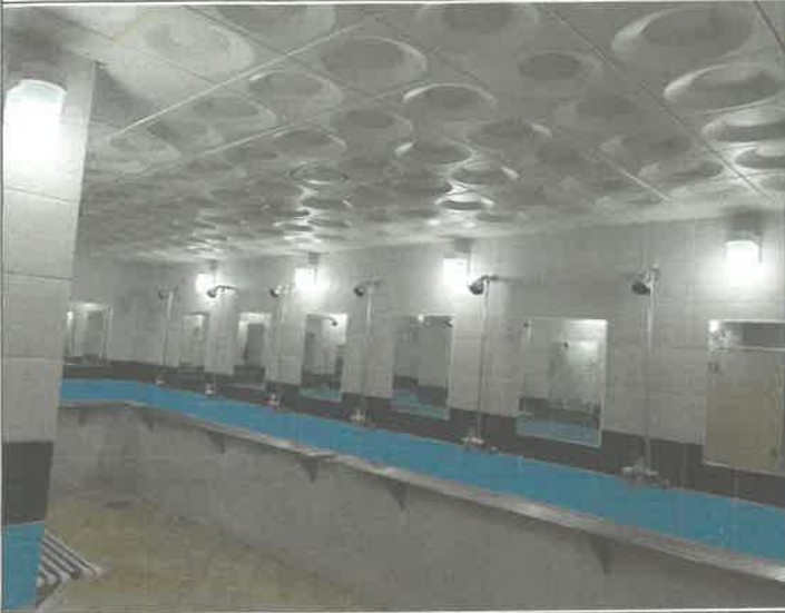
수영장 남자 샤워장 내 벽등 1개소 전구 교체
