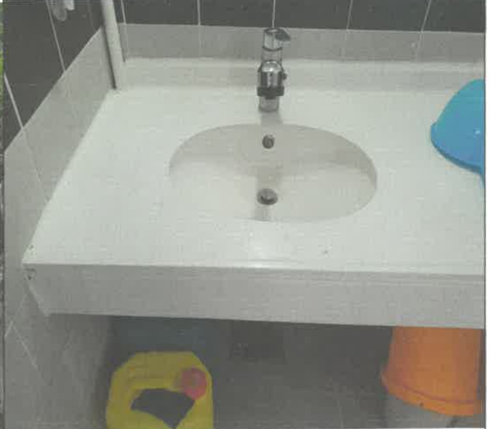
수영장 여자 샤워실 세면대 통수
