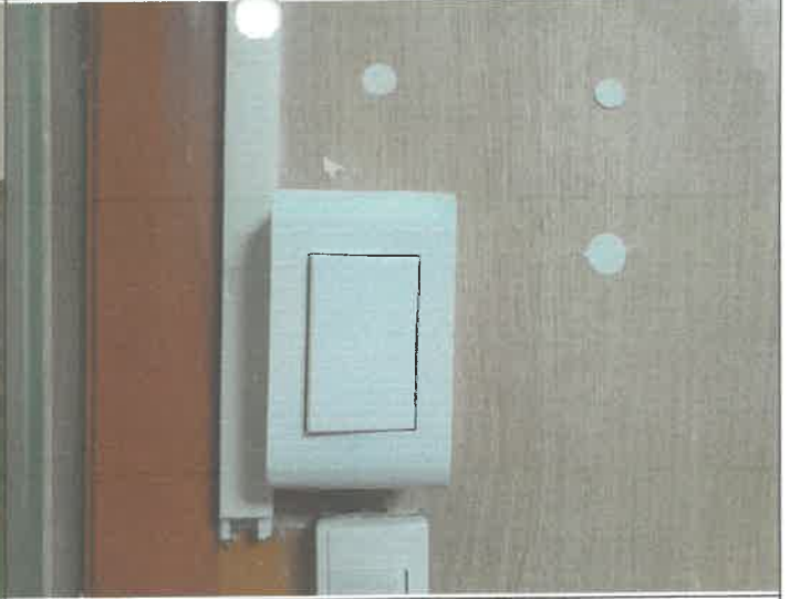
수납 천장 등 단독 스위치 설치
