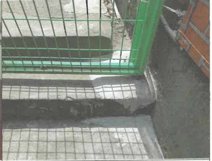
주차장 쓰레기분리장 철문 안카고정 및 시멘트 포장
