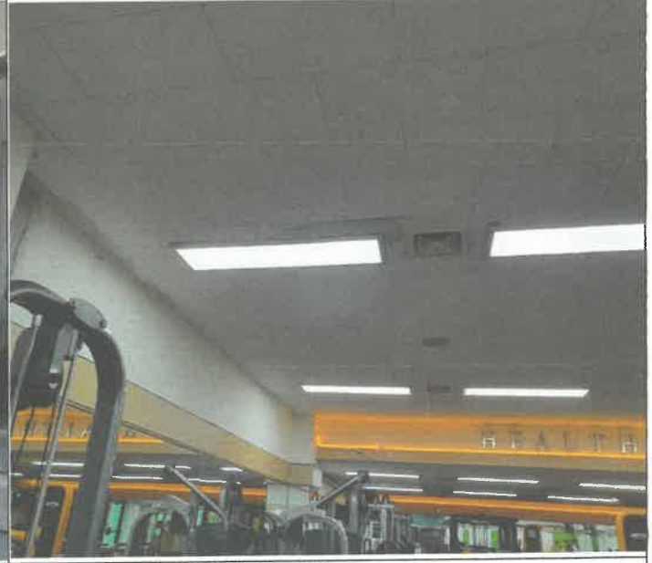
2층 유스6실 개수대 배수관 파열로 하부 헬스장 청장 누수 하수배관 교정
