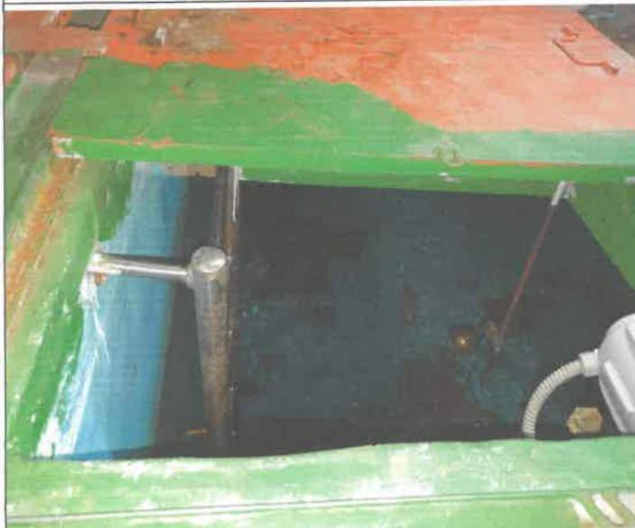
상반기 저수조 청소 (기계실 저수조)
