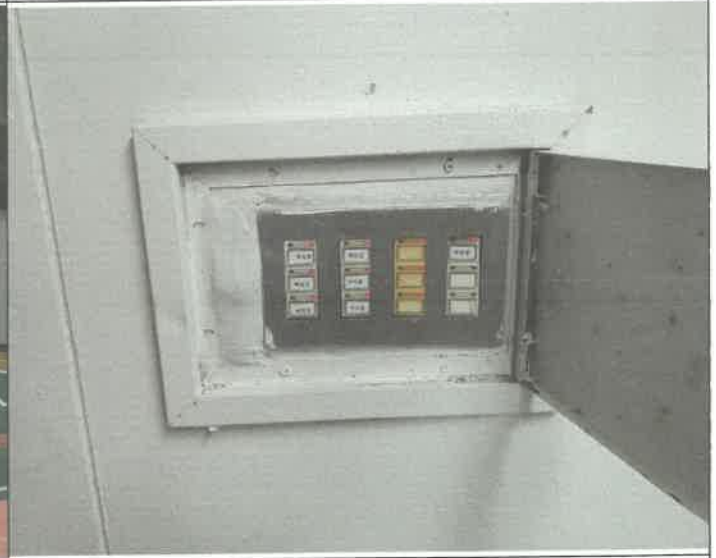
강사 대기실 수영장 등 스위치 커버 탈거 되어 제설치
