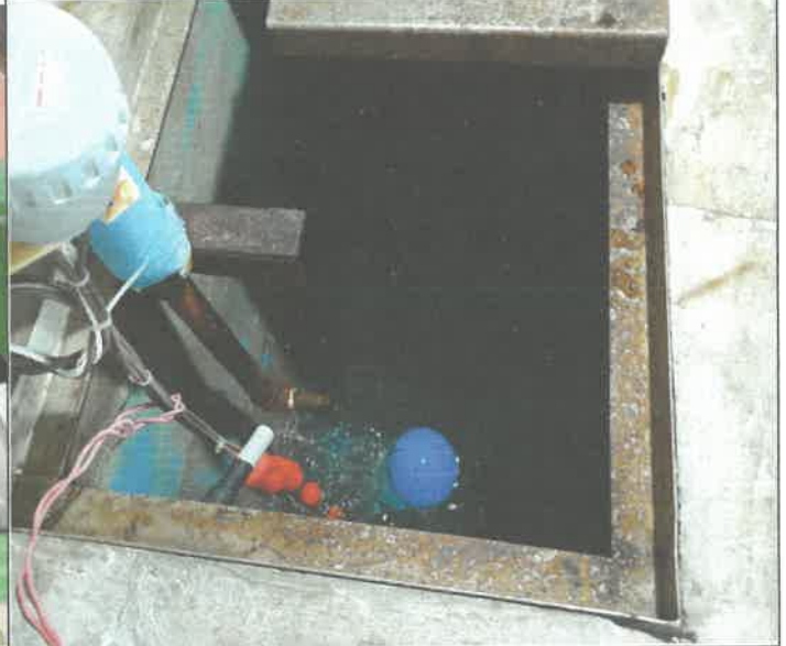
상반기 저수조 청소 (지하 비트 바란심 탱크)
