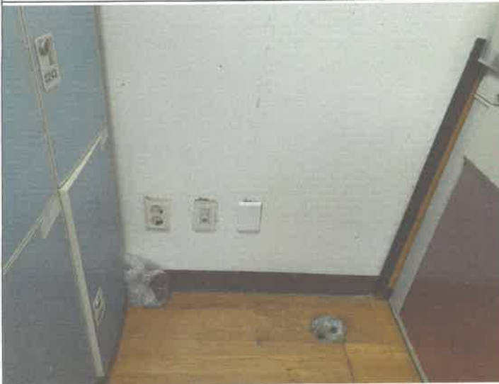
지하 1층 수영장 임대 락카룸. 락카 전화 콘센트 맨커버 교체
